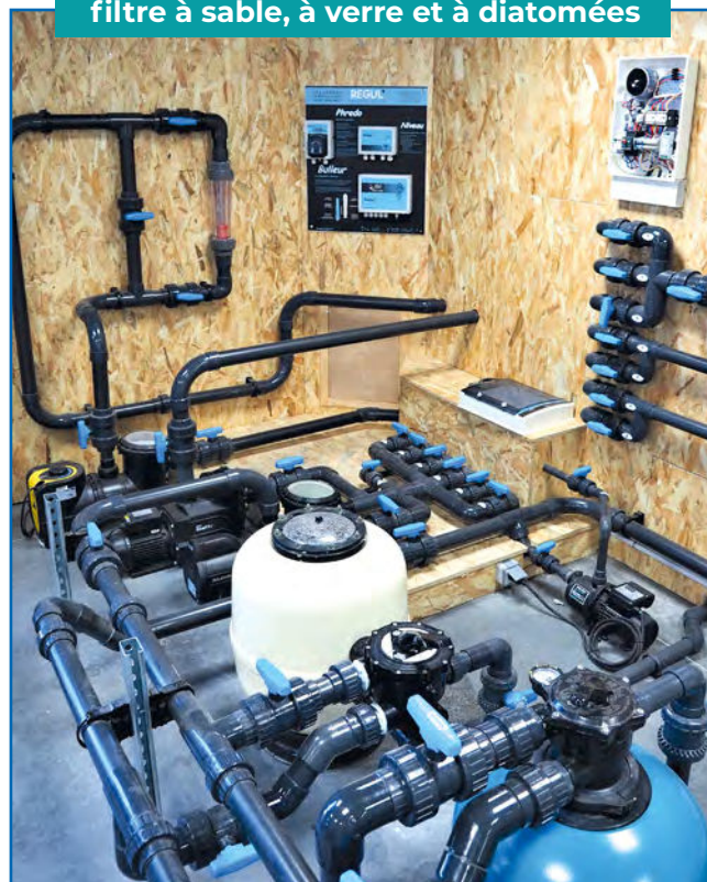
Local technique du bassin extérieur composé de 3 filtres : filtre à sable, à verre et à diatomées
